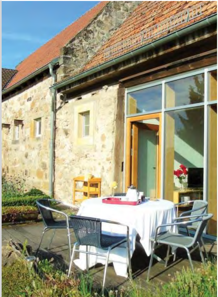
Umbau Nebengebäude zur Ferienwohnung, Köslau Amt für ländliche Entwicklung Unterfranken
